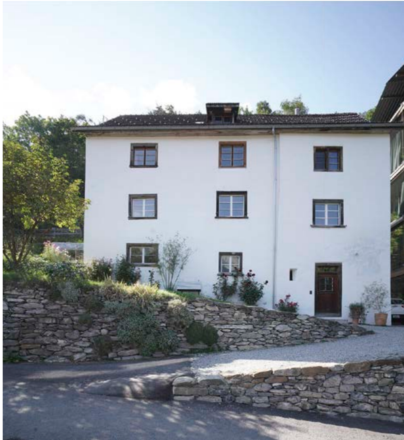
OBEN: Eingangsseite nach Sanierung mit neu abgefangenen und gestalteten Außenanlagen
