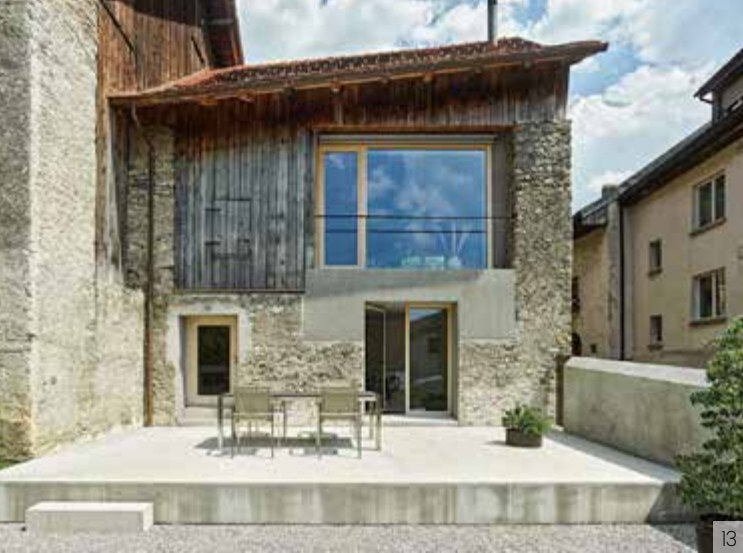
13 Die Aussenhaut des Stalles wurde weitgehend respektiert, indem am alten Stein und Holz nur wo nötig geflickt und bewusst nichts erneuert wurde.
